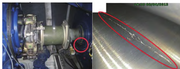
(a) 传感器安装位置 (b) 故障轴承
