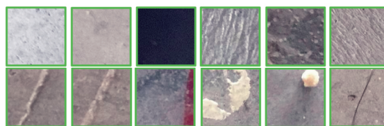
(a) 无裂缝图像
